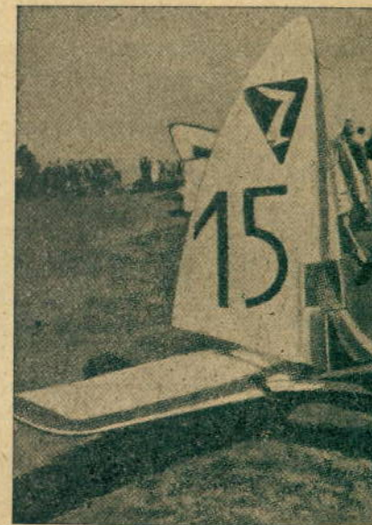
Фиг. 39. Хвостовое оперение планера «Луфтикус» (паритель Берлинского кружка).
